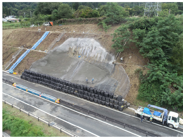
▲応急復旧作業状況
