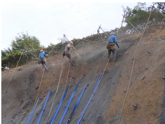
▲モルタル吹付状況（日特建設（株） 施工）
