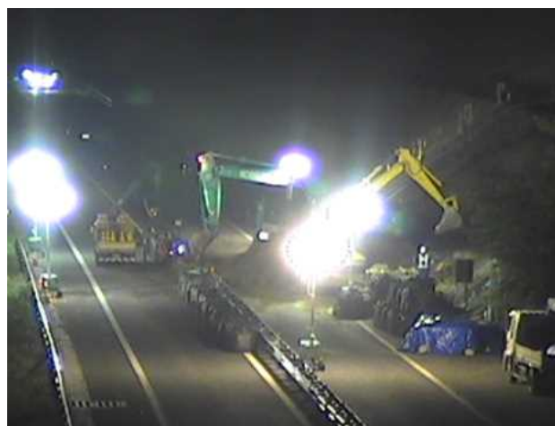
▲土砂撤去作業状況（（株）テラ 施工）
