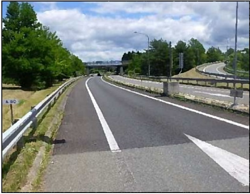
舗装補修完了後イメージ
