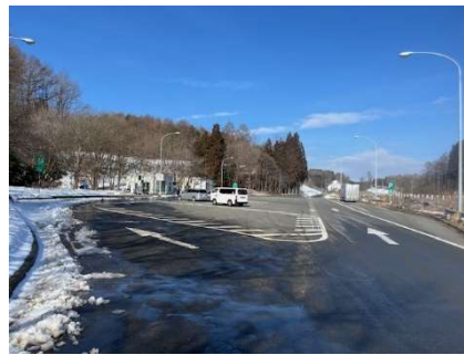
前森山 PA(下り線)状況
