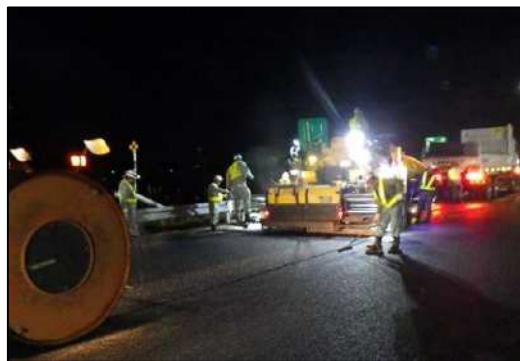
舗装補修工事 作業状況
